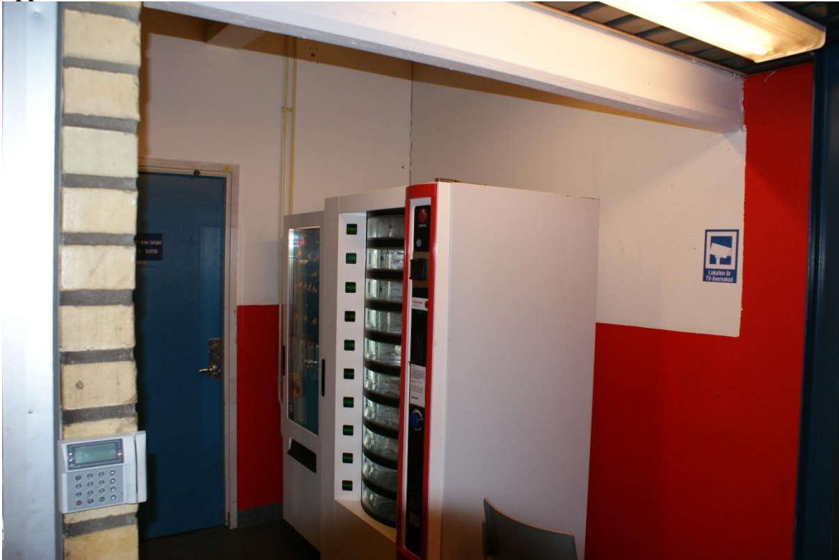
Figur 26 Automat i utrymningsvägen, PB73
