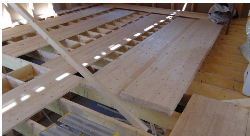
Figur 3: Råspontluckor används som landgång på bjälklaget.
