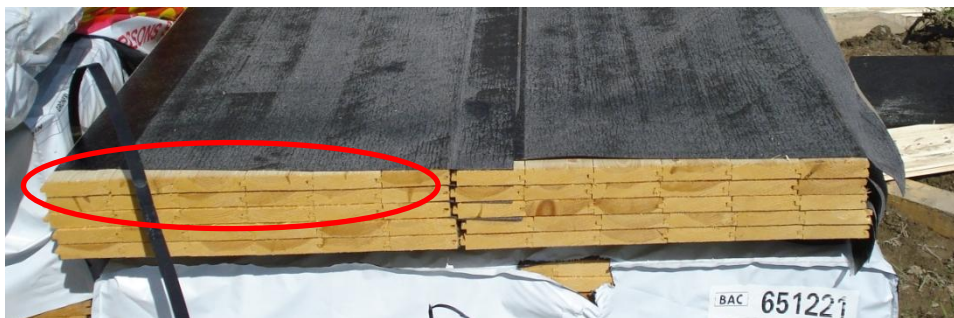
Figur 4.5: Papp når inte ända ut till kant på råspontlucka.
