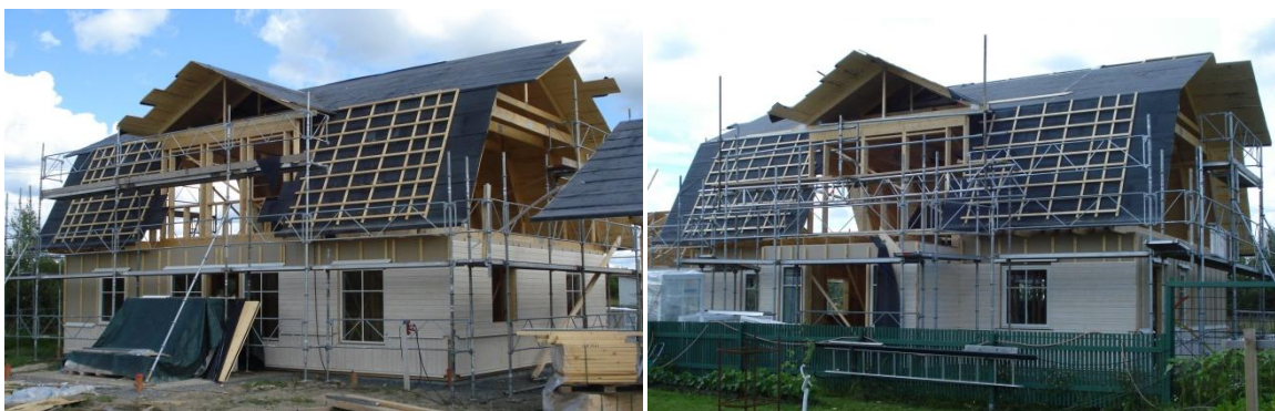
Figur 3: Takläggning av husets kupor den 18 juli 2012.
