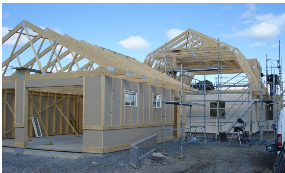
Figur 4.3: Hus och garage före råspontläggning.
