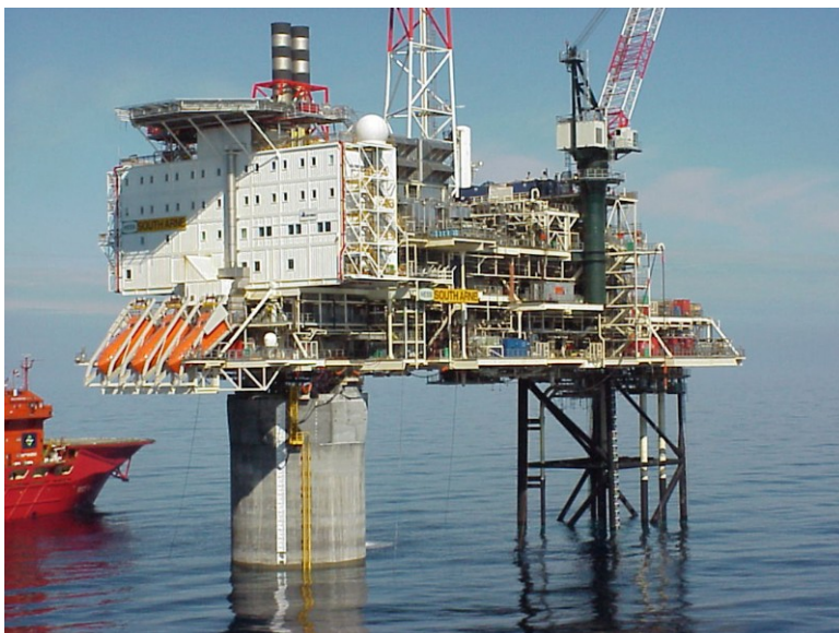
Figur 2.2. Den vita byggnaden är livingquarters
