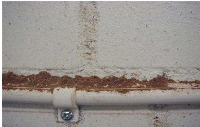
Bild 5.1: Foto som visar väggen bakom tavlan.
