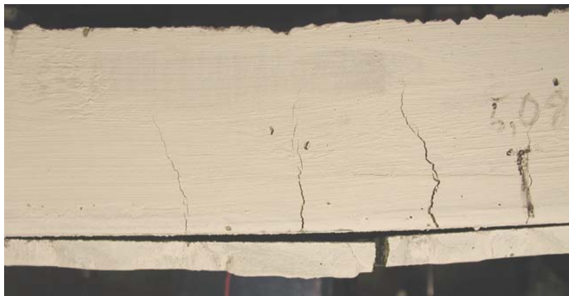
Bild A4. Fiberbrott för platta 3. Vidhäftningsbrott mellan pågjutningen och betongplattan har uppstått efter fiberbrott, då nätet rekylerar tillbaka till sin ursprungliga form med stor kraft.
