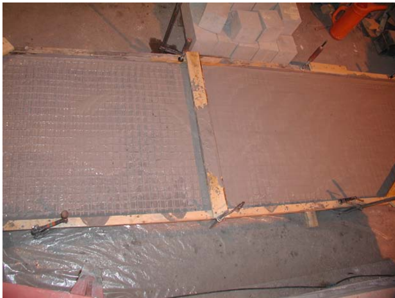
Bild 12.2. Betongplattan med gjutform under pågjutning av polymerbetong innehållande kolfibernät.
