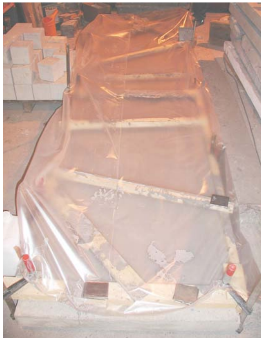
Bild A9. Skyddsplast placerad över gjutning med polymerbetong för att förhindra krympsprickor under härdningsförloppet.
