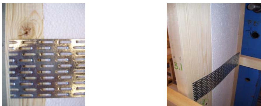
Figur 4.14 Provkropp 3.2 övre förband (till vänster). Provkropp 3.1 efter brottet med böjd spikplåt nr.3 (till höger).
