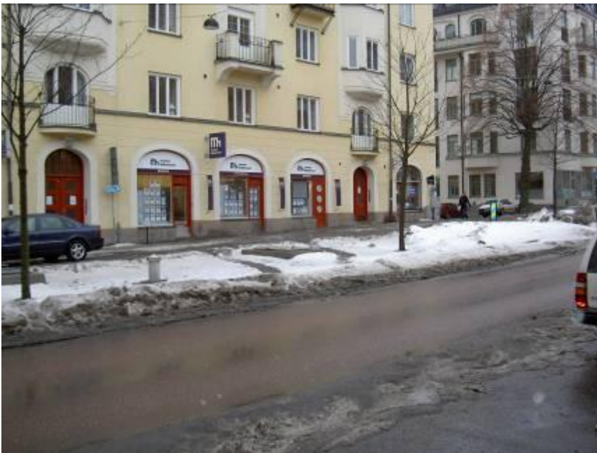
Figur 10. Dagvattnet på Råsundavägen dräneras genom grus i gatans mittsektion och leds sedan till en reningsdamm i Solparken.
