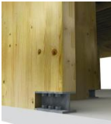
Stabiliseringselementen fästs till grunden via utrymmessnäla beslag. Foto: Moelven
