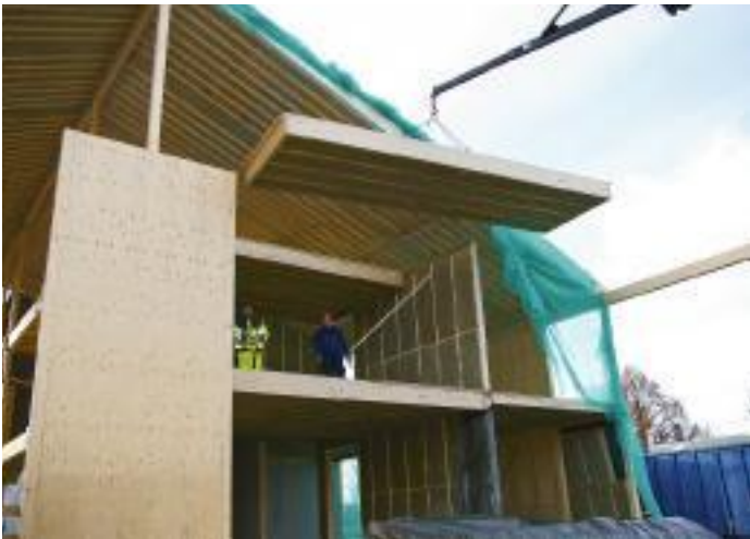
Montage av bjälklag. Stabiliserings-elementen till vänster i bild.
