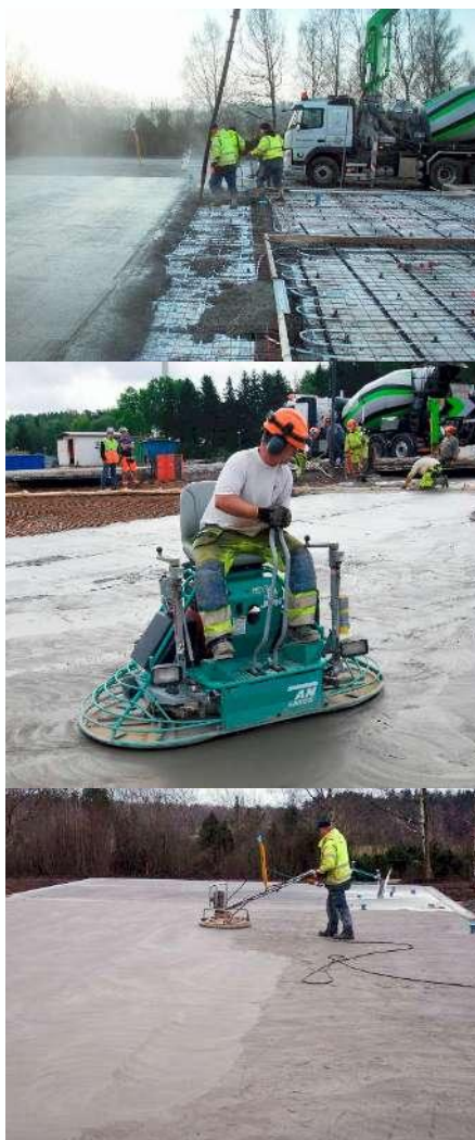
Figur 1. Gjutning av platta vid kall väderlek, maskinglättning med åkglättare och med handhållen glättare.
