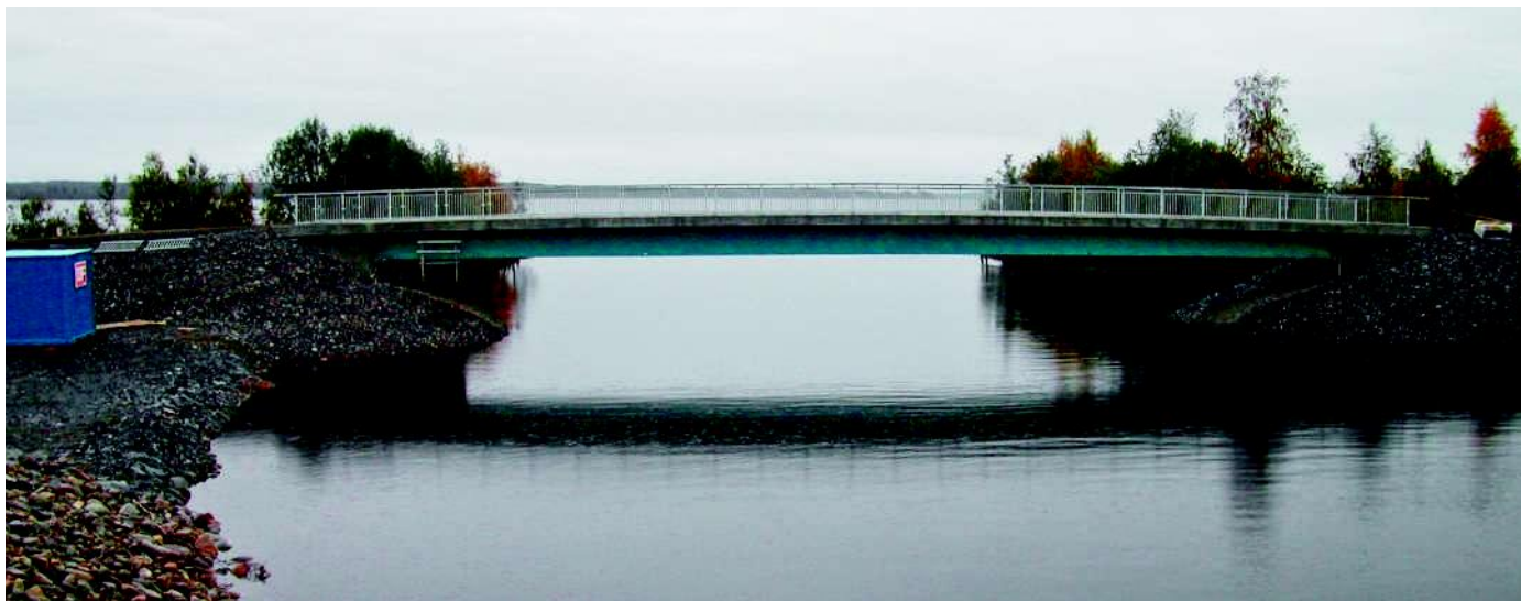
Figur 1: Den byggda samverkansbron över Leduån med integrerade landfästen.
