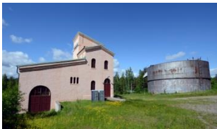
Bild 1. Stationsbyggnaden. Den lägre delen rymmer maskinhallen, i tornet finns högspänningsställverk och kontrollutrustning. Till höger svalltornet.
