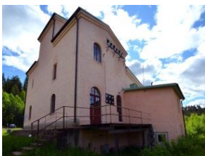
Bild 2. Stationsbyggnaden, med tillbyggnaden från 1950-talet. Vid restaureringen märktes tydligt stora kvalitetskillnader i materialen och byggnadskvalitet mellan den ursprungliga byggnaden och tillbyggnaden. Tillbyggnaden hade drabbats av sättningar, putsen var i betydligt sämre skick och fönstren var rötskadade.
