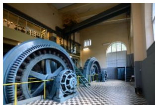
Bild 8. Maskinhallen, med generatorer och mataremaskiner. Väggarna är rengjorda och målade, klinkergolvet reparerat liksom porten.
