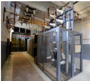
Bild 4. Högspänningsställverket, i tornets ovanvåning. Före restaureringen flagnade färgen på väggarna.
