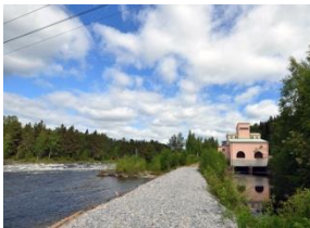
Bild 7. Kraftstationen intill älven. Maskinhallen, med de karaktäristiska höga, välvda fönstren som skulle ge maximalt med ljusinsläpp.
