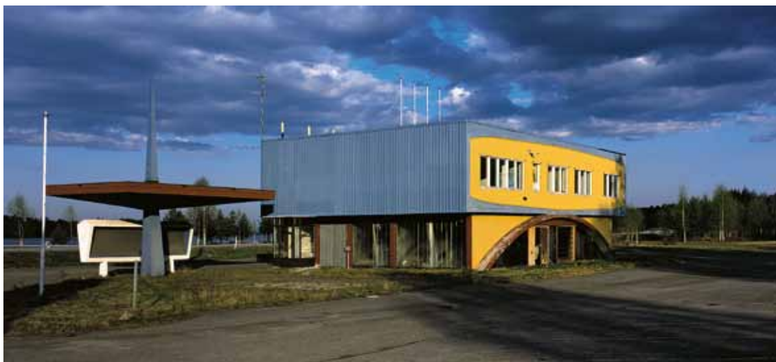
Turiststationen före restaureringen. Den präglas av en kraftfull färgsättning, och valvbågen är igensatt. Foto:Daryoush Tahmasebi © Norrbottens museum.
