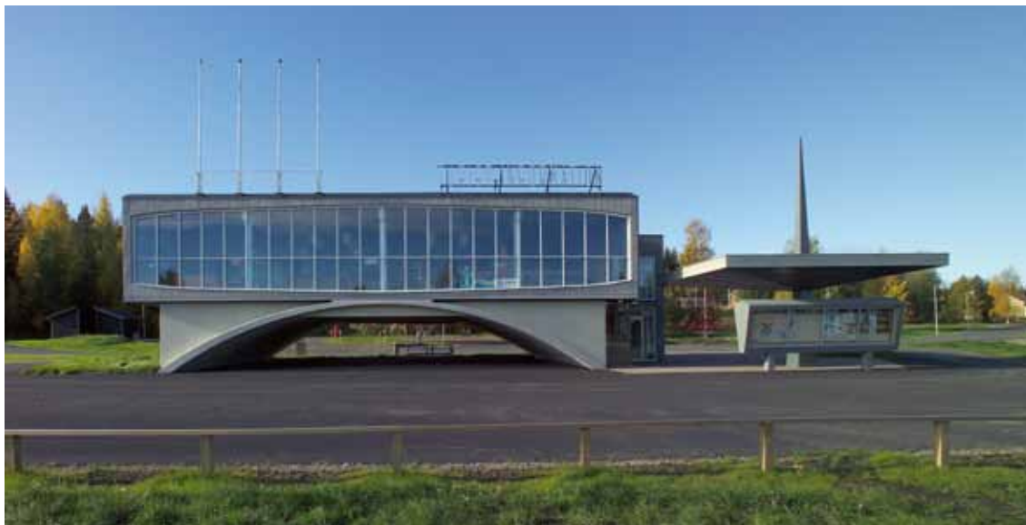
Turiststationen, efter avslutad restaurering. Valvbågen är återställd, liksom panoramafönstret. På byggnadens högra sida syns ett tillbyggt hisschakt. Foto:Daryoush Tahmasebi © Norrbottens museum.
