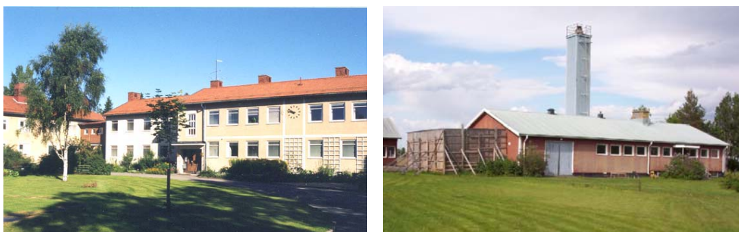
Figur 7. Huvudbyggnad Palogården (till vänster) och Palogårdens värmecentral inklusive flislager (till höger)
