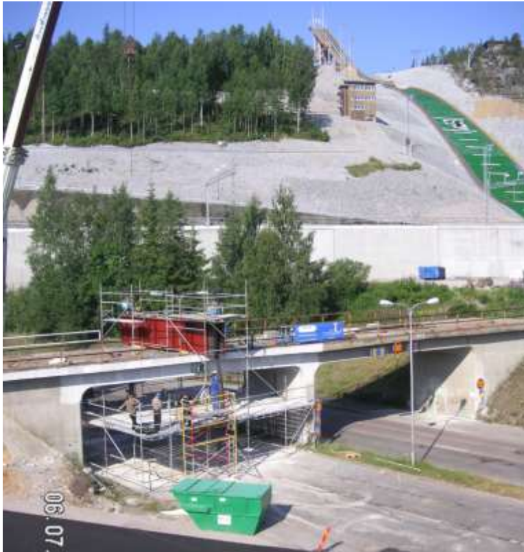
Figur 2.1: Bro i Örnsköldsvik provad till brott 2006 i EU-projektet "Sustainable Bridges", SB(2008), Puurula et al. (2008, 2012, 2013, 2014).
