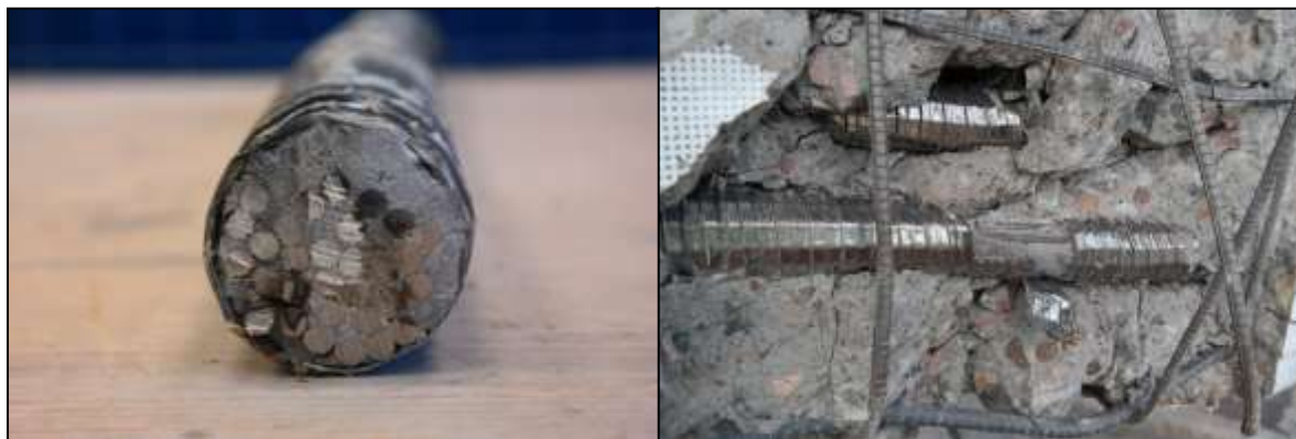
Figur 5.8: Kablar efter provning, Bagge et al. (2015f).
