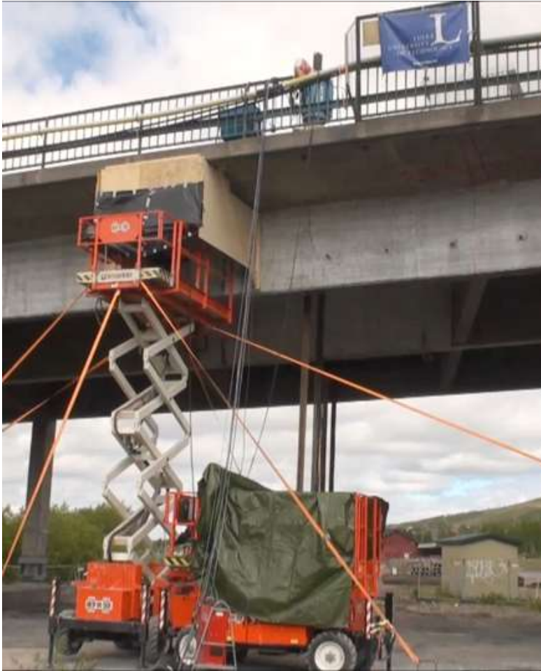
Figur 3.3: Töjnings- och deformationsmätning med fotometrisk utrustning (skyddad mot ljuspåverkan) på utsida balk. Se Sas et al. (2011, 2012) och SB 7-3(2008) för motsvarande mätning vid provning av bron i Örnsköldsvik.
