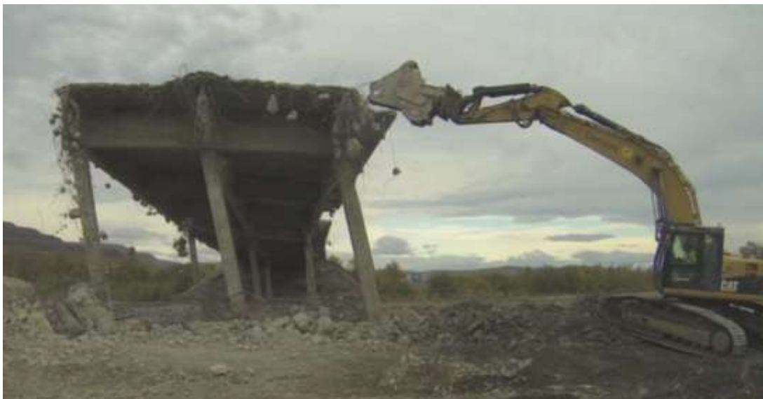
Figur 5.3: Segt brott tvärläng vid rivning av Gruvvägsbron.
