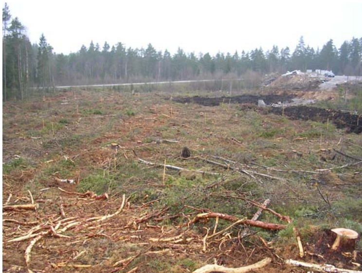
Figur 31 Bild på saneringsområdet efter avverkning av skog och innan schaktning av torv påbörjats. Det kan noteras att området är täckt av en stor del grenar och ris som till viss del röjdes bort men som även lämnades och följde med när torven schaktades.
