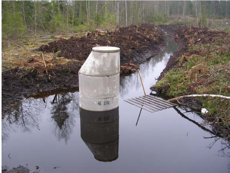
Figur 32 Kärret dikades ur innan saneringen påbörjades. En brunn placerades mitt i saneringsområdet för att vid behov kunna pumpa vatten till en reningsanläggning under schaktarbetet.
