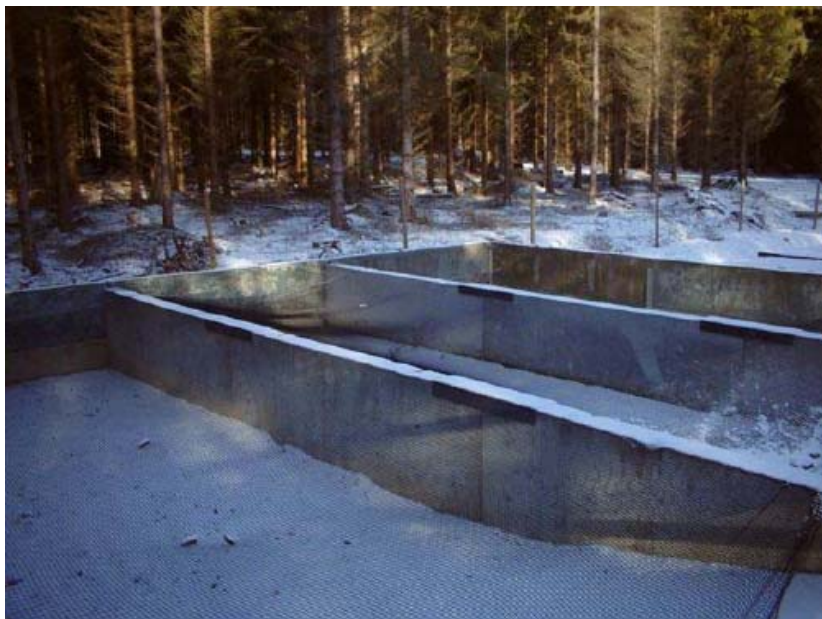
Figur 36 Visar den anlagda slamtorkbädden vid Ekerödsrasten, två delar används för slamtorkning och den tredje som kompostupplag (Hörby Kommun 2007).
