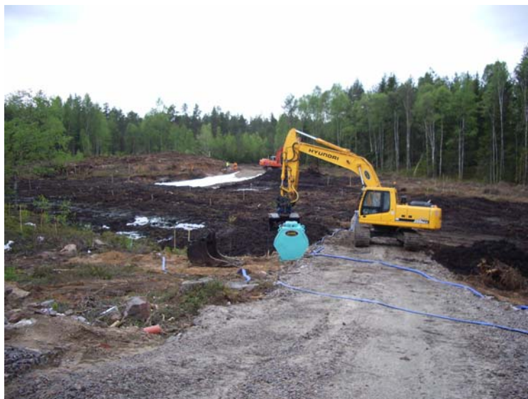
Figur 33 Bild från pågående schaktningsarbete. Området hade indelats i schaktrutor med olika föroreningsklassning på olika nivåer vilket innebar att olika rutor skulle schaktas olika djupt.
