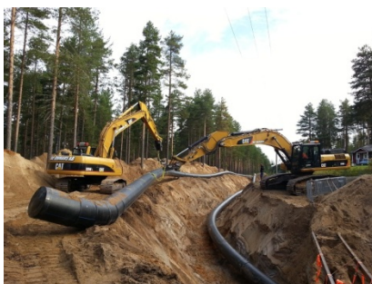
Tunnling under befintliga segjärn 400 mm
