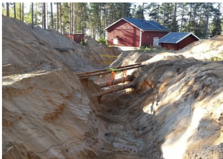
Upphängning av befintliga 400 mm ledningar
