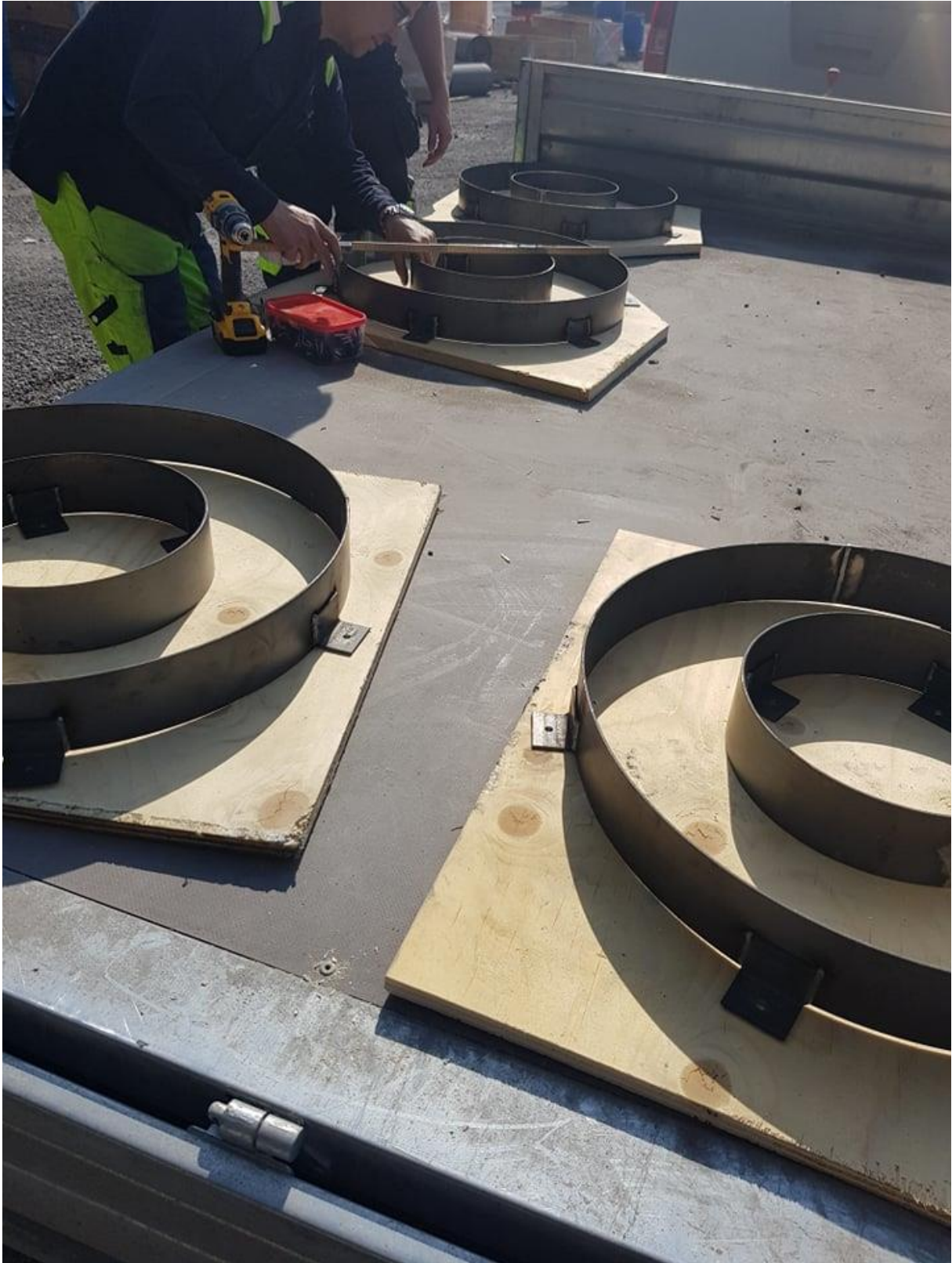
Bilaga 2 Montering av stålformar.
