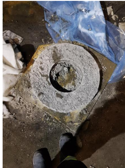
Figur 4. Prov 2, Sprutbetong vattenhärdad.
